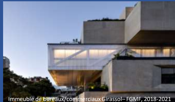
Immeuble de bureaux/commerciaux Girassol– FGFM, 2018-2021
